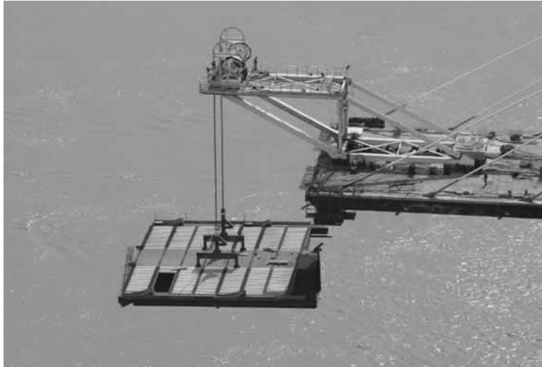
Рис. 4. Монтаж сегментов подвесных мостов при помощи «strand jack» [5]
