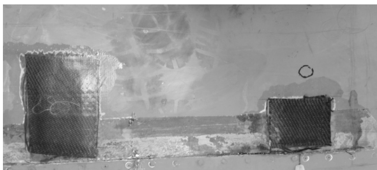
Рис. 7. Ремонтные накладки после проведения ремонта
