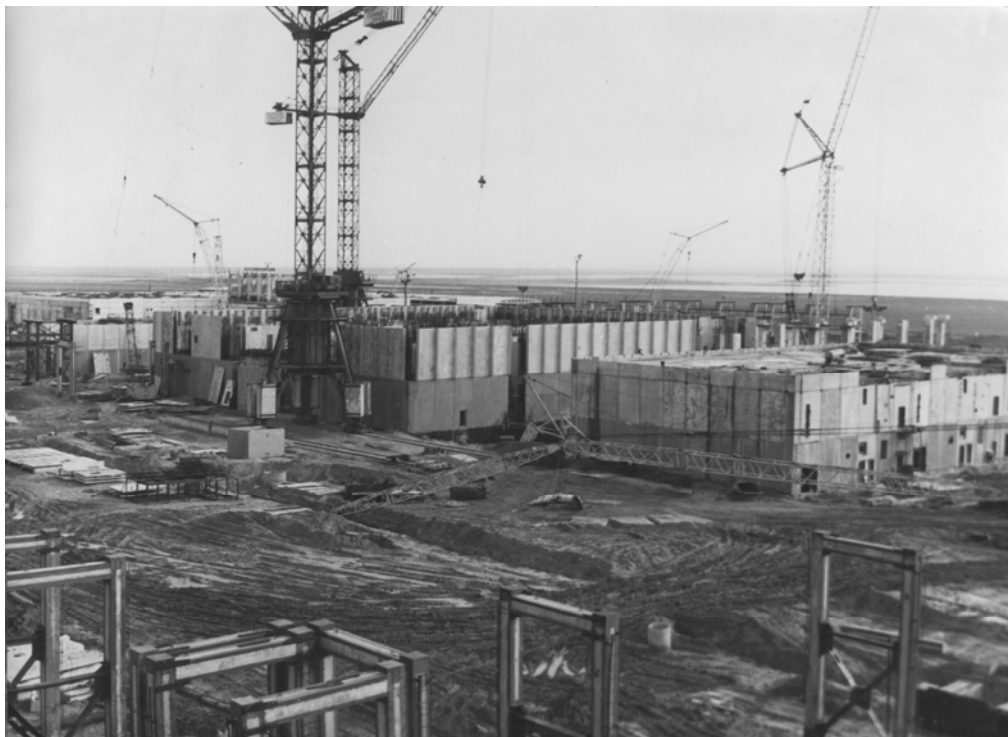
Рис. 1. Строительство Крымской АЭС
